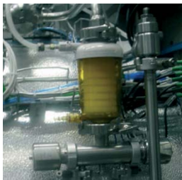
Decontamination of exhaust air with sterile filter / Dekontamination der Abluft mit Sterilfilter
